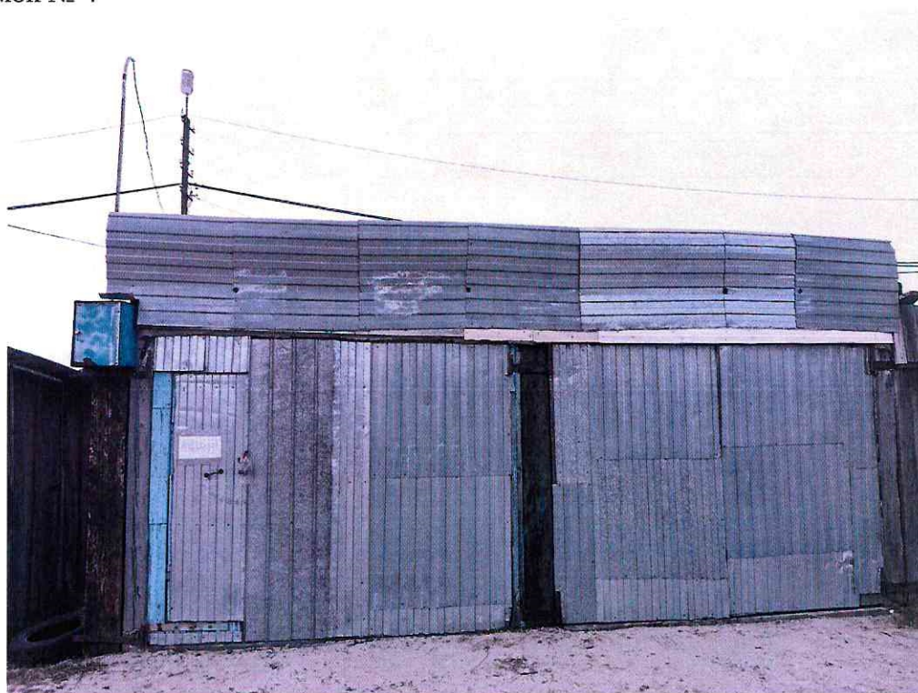
(Объект № 113 – деревянный гараж.)
