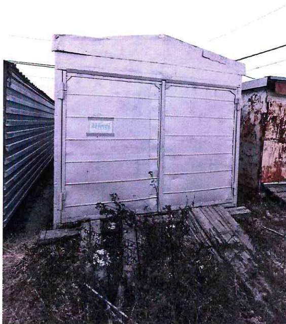
(Объект № 118 – металлический вагон-гараж.)
