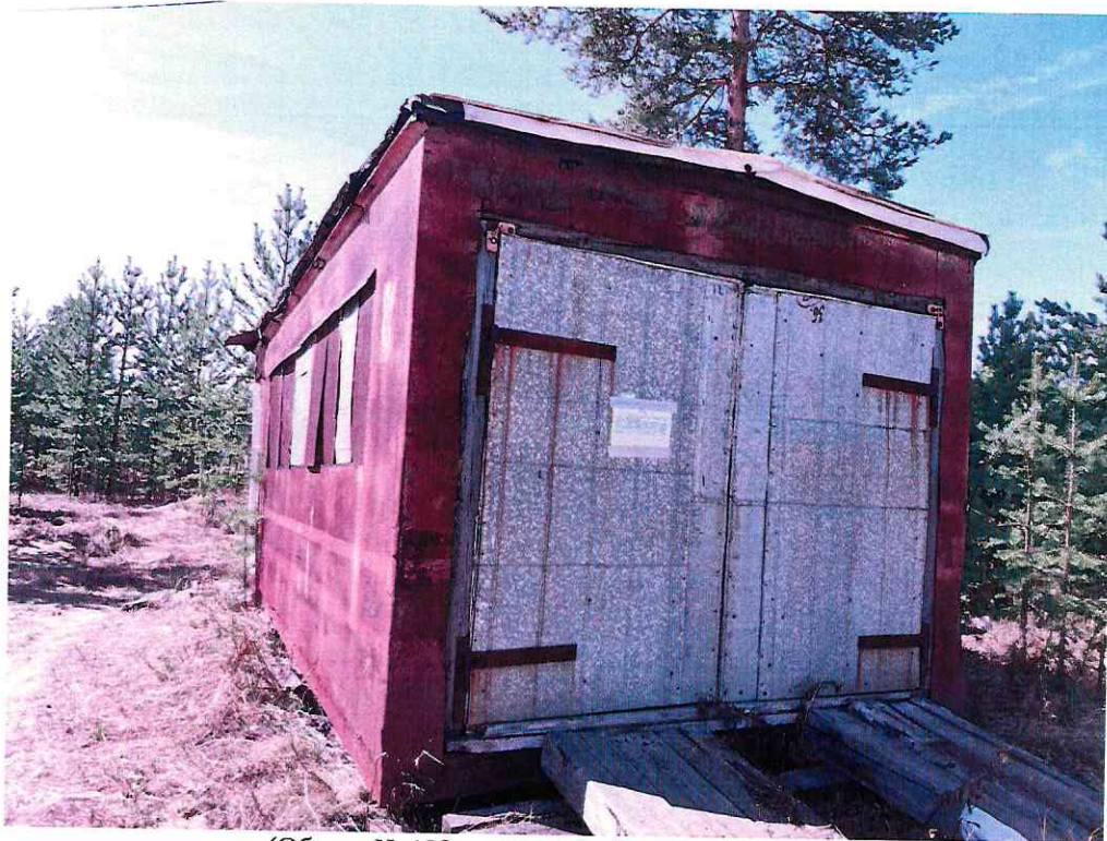
(Объект № 123 - металлический вагон-гараж.)
