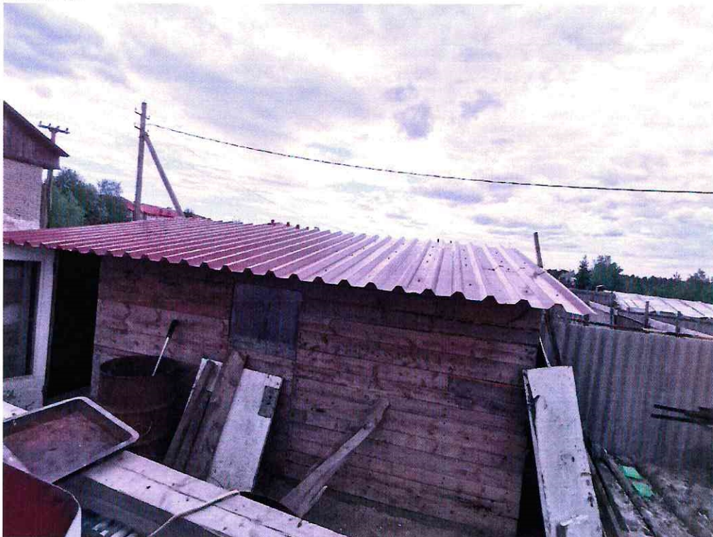
(Объект № 147– деревянная хозяйственная постройка.)
