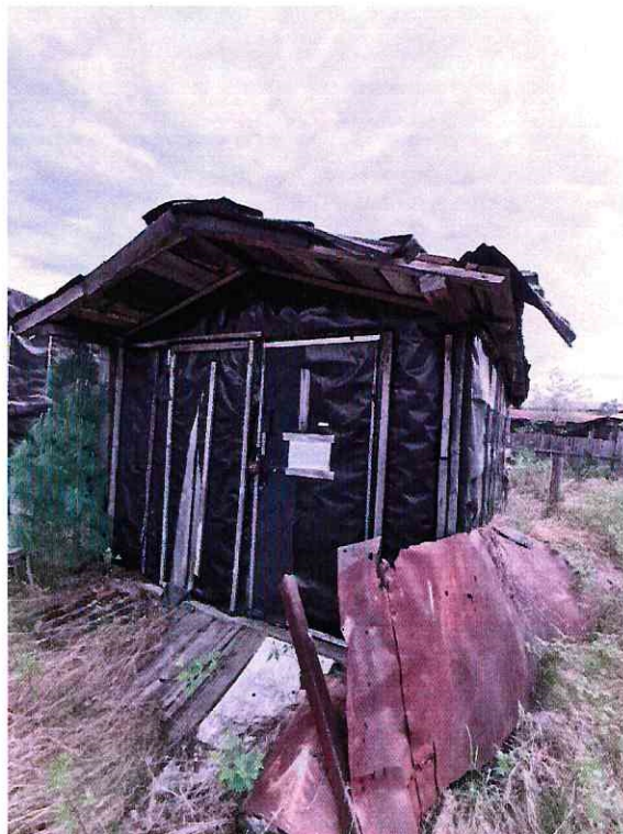
(Объект № 155–деревянный гараж.)
