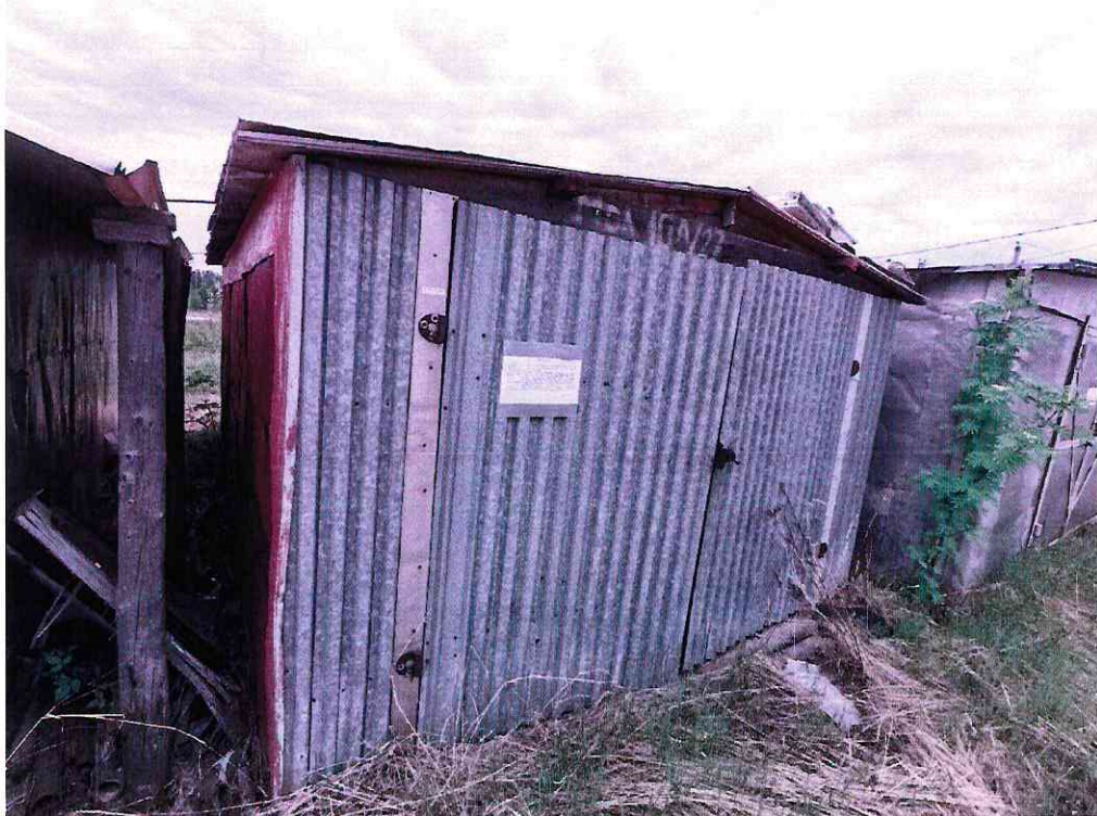
(Объект № 159–металлический гараж.)
