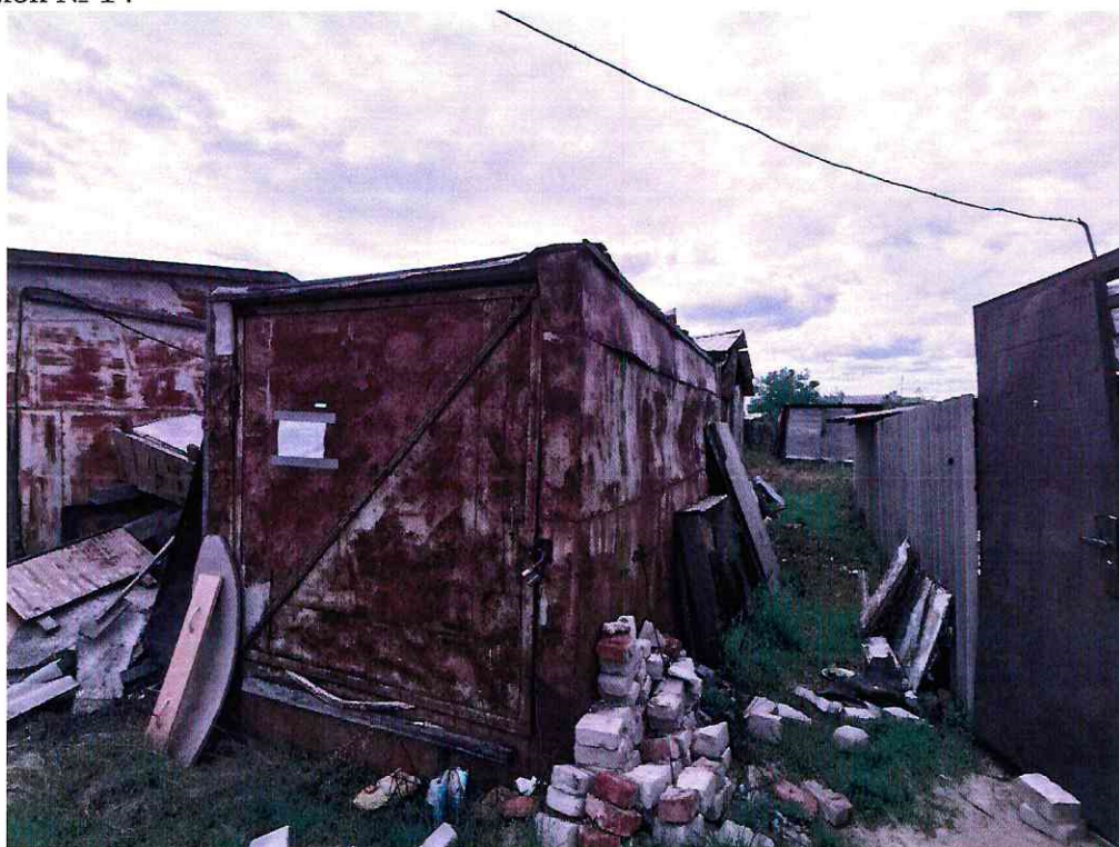
(Объект № 149–металлический вагон.)
