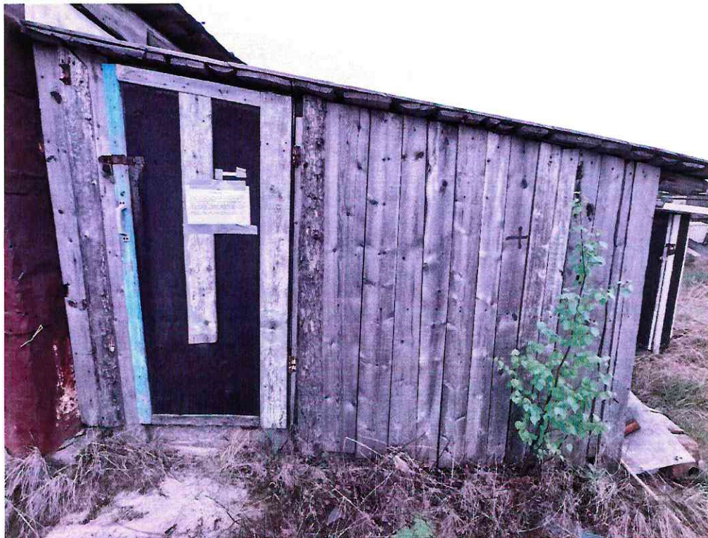
(Объект № 178—деревянная хозяйственная постройка.)
