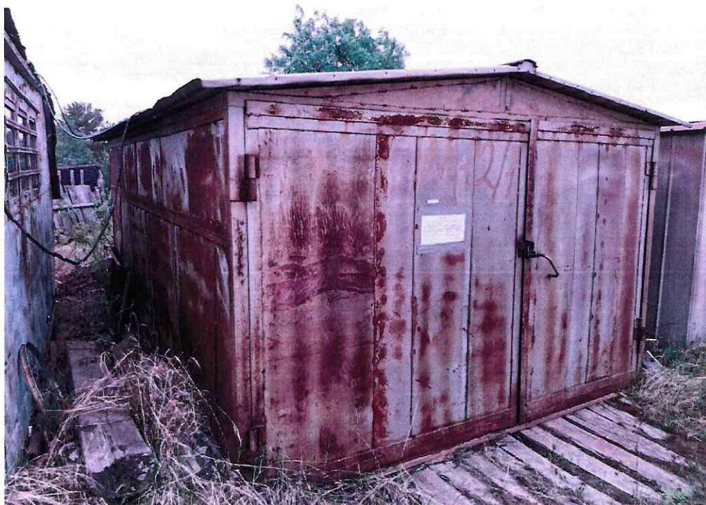
(Объект № 163–металлический гараж.)
