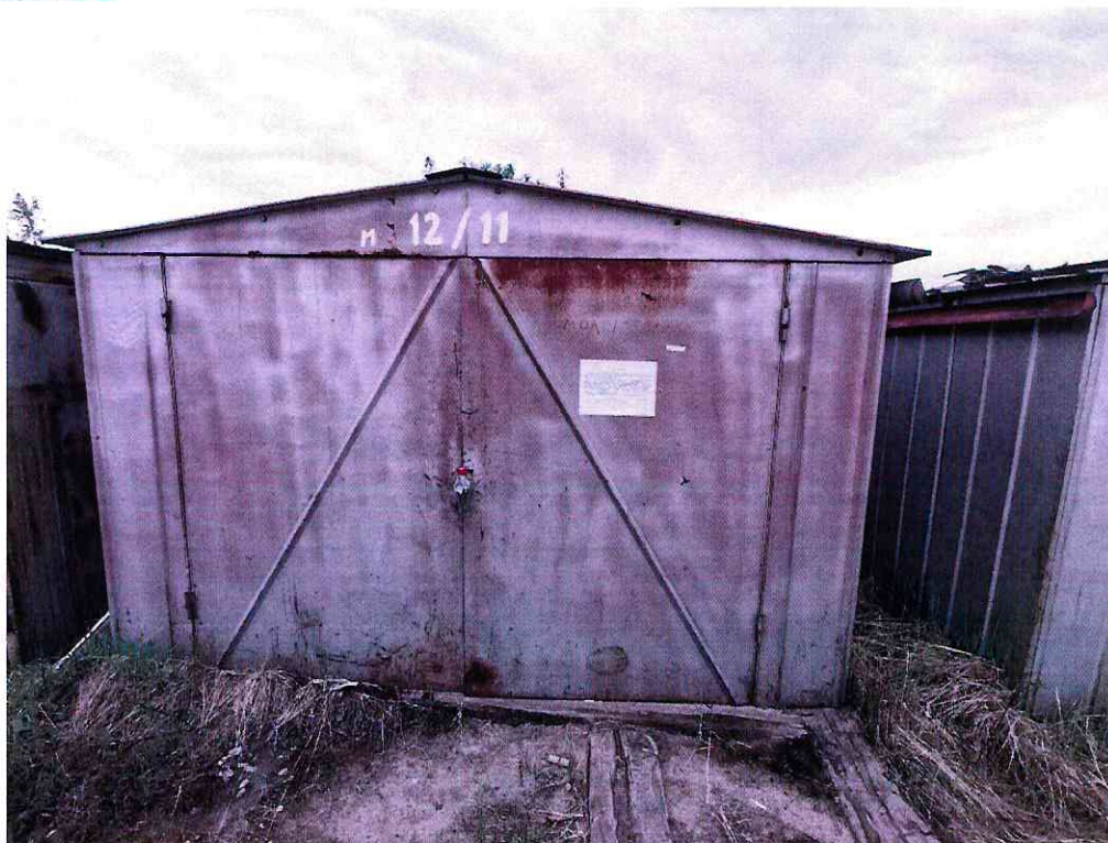
(Объект № 162–металлический гараж.)
