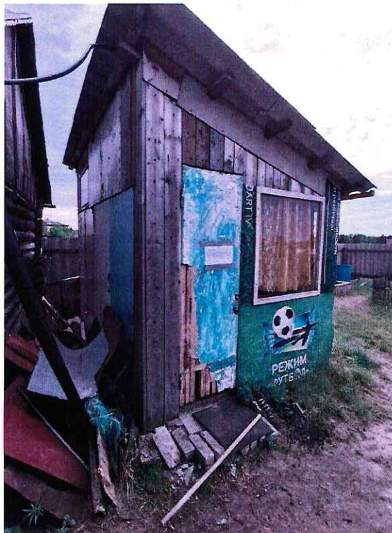
(Объект № 152—деревянная хозяйственная постройка.)
