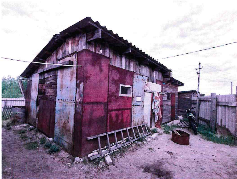
(Объект № 150–деревянная хозяйственная постройка.)
