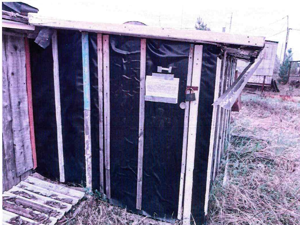
(Объект № 179—деревянная хозяйственная постройка.)
