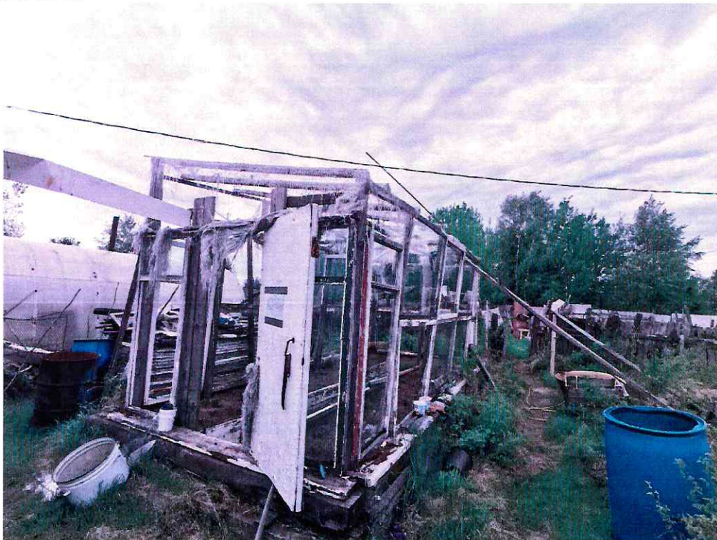
(Объект № 145– деревянная теплица.)
