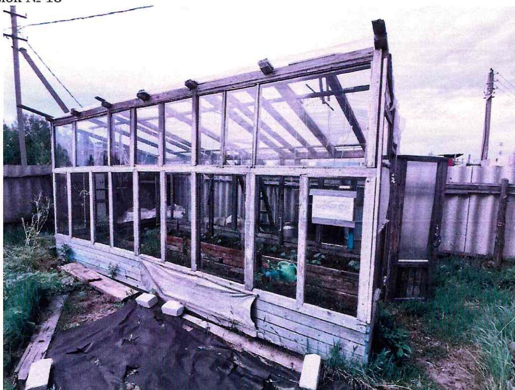
(Объект № 153—деревянная теплица.)
