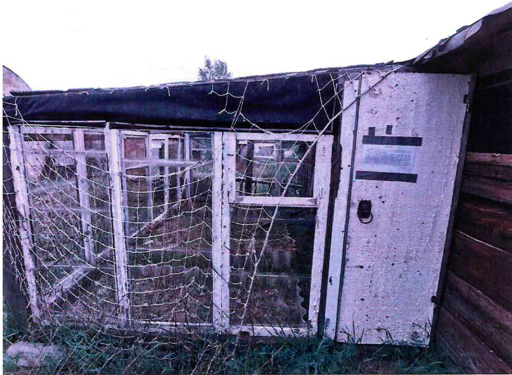
(Объект № 176–деревянная теплица.)
