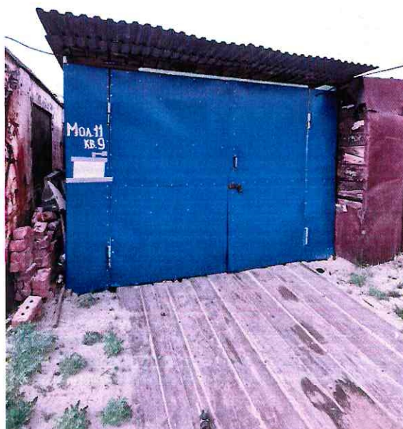
(Объект № 188–металлический гараж.)
