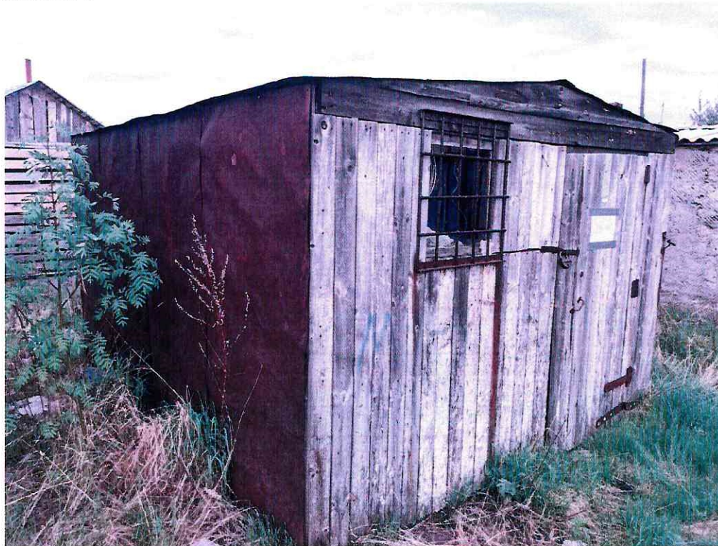
(Объект № 138– деревянная хозяйственная постройка.)
