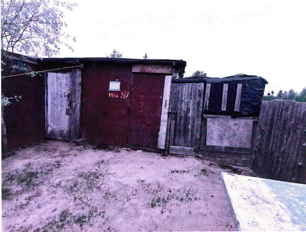
(Объект № 168 деревянная хозяйственная постройка.)
