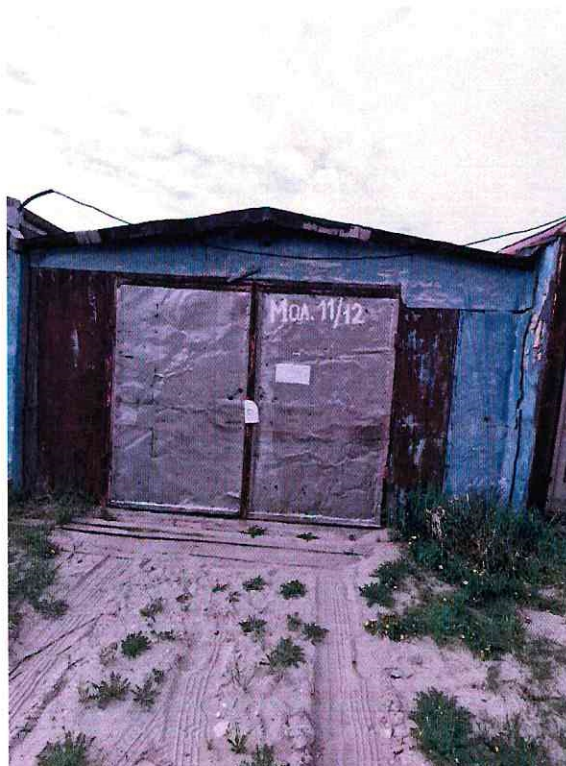
(Объект № 190–металлический гараж.)
